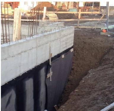
Le fondazioni dei muri perimetrali e portanti saranno in cemento armato di tipo continuo in conglomerato cementizio armato antisismico e tutte collegate tra loro, della sezione e profondità che deriveranno dai calcoli statici e dalla natura del terreno. La faccia esterna a contatto col terreno verrà protetta da apposita guaina da mm4, onde evitare infiltrazioni d'acqua dall'esterno e da guaina antiradice bugnata
