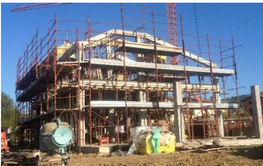
Struttura a Telaio In Ca. a norma antisismica composta da travi e pilastri realizzate con calcestruzzi e acciai di adeguata resistenza caratteristica e della migliore qualità.
