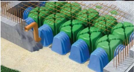
Formazione di vespaio Areato compreso di soletta in c.a. superiore di spessore cm 4, mediante il posizionamento, su piano preformato, di elementi plastici tipo CUPOLEX. Tale Vespaio ha il compito di interrompere la risalita dell'umidità e disperdere il gas radon eventualmente presente nei terreni
