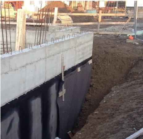
Le fondazioni dei muri perimetrali e portanti saranno in cemento armato di tipo continuo in conglomerato cementizio armato antisismico e tutte collegate tra loro, della sezione e profondità che deriveranno dai calcoli statici e dalla natura del terreno. La faccia esterna a contatto col terreno verrà protetta da apposita guaina da mm4, onde evitare infiltrazioni d'acqua dall'esterno e da guaina antiradice bugnata
