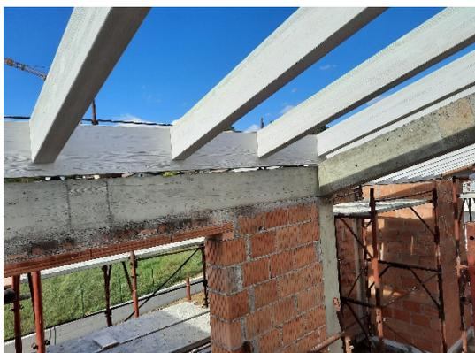
Copertura in legno lamellare ventilata dimensionata per un carico permanente (compr. peso proprio) 105+10 kg/m<sup>2</sup>,carico neve 120 kg/m<sup>2</sup>.
