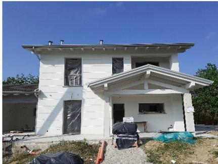
Per quanto riguarda le murature dell'autorimesse saranno realizzate con Blocchi in laterizio modulari spessore cm 25 rivestiti con intonaco. All'esterno verrà tinteggiato con due mani di pittura Acrilsilossanica per esterni fino a perfetta copertura; colore definito dalla D.L..
