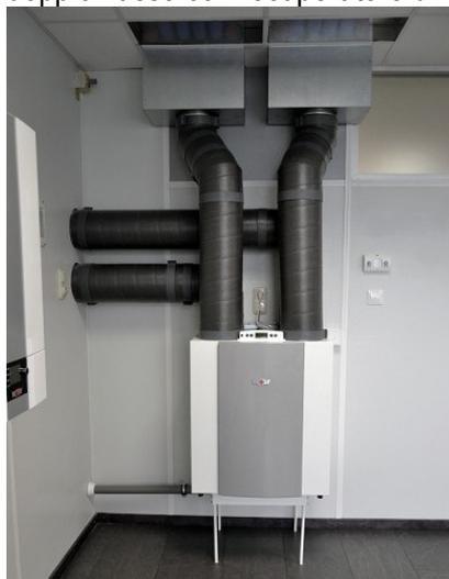
Un sistema di ventilazione meccanica controllata con recupero di calore è necessario per poter soddisfare i requisiti di classe energetica A4 di un edificio, garantendo nel contempo agli occupanti un buon comfort termigrometrico che non sarebbe ottenibile senza un'adeguata ventilazione;
