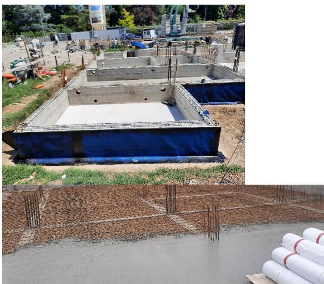
Le fondazioni dei muri perimetrali e portanti saranno in cemento armato di tipo continuo in conglomerato cementizio armato antisismico e tutte collegate tra loro, della sezione e profondità che deriveranno dai calcoli statici e dalla natura del terreno. La faccia esterna a contatto col terreno verrà protetta da apposita guaina da mm4, onde evitare infiltrazioni d'acqua dall'esterno e da guaina antiradice bugnata.
