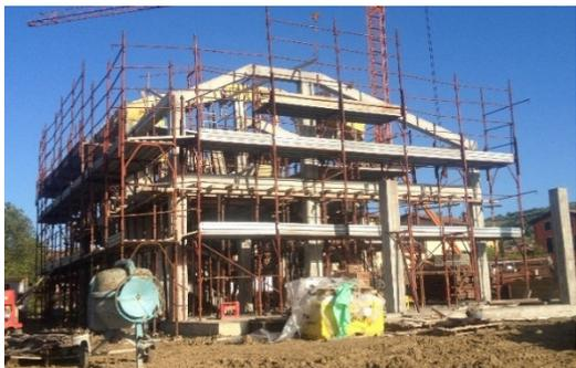
Struttura a Telaio In Cemento armato a norma antisismica composta da travi e pilastri realizzate con calcestruzzi e acciai di adeguata resistenza caratteristica e della migliore qualità.
