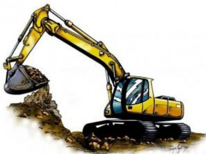
Scavo di sbancamento completo eseguito con escavatore meccanico, comprese le eventuali sbadacchiature, il reinterro e la sistemazione del materiale di scavo alle pubbliche discariche.
