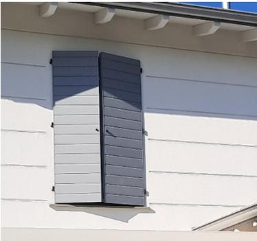
In cucina, nelle due camere da letto singole, nel locale tecnico, e nel bagno al piano primo è previsto come oscuramento scuri in alluminio a doghe orizzontali a scandola.
